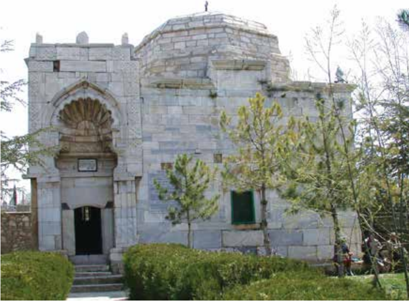
Aşık Paşa Türbesi
